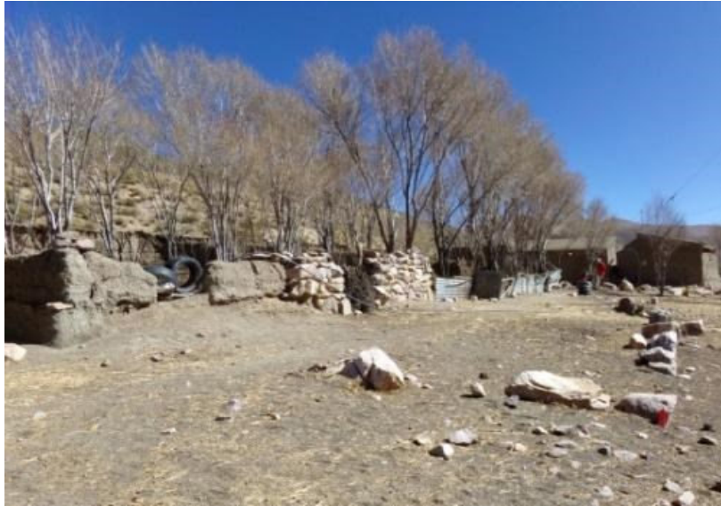
[fig. 8] Base estructural de la Posta de Casillas (Imagen: Ramundo)
